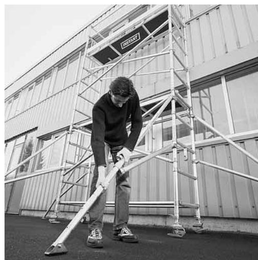
Figure 3: la notice de montage indique à partir de quelle hauteur et comment les appuis doivent être installés.
