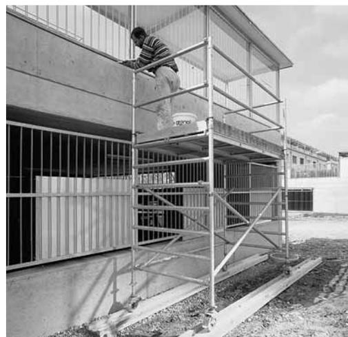
Figure 2: un support résistant empêche l'échafaudage roulant de s'enfoncer brutalement.
