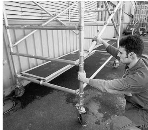
Figure 1: des échafaudages roulants en bon état sont une condition sine qua non pour un travail sûr.
