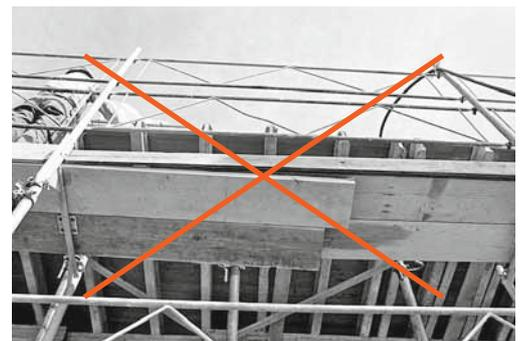
Fig. 3: les plateaux posés en porte-à-faux constituent un danger caché, car on ne s'en rend pas compte quand on les voit d'en haut.
