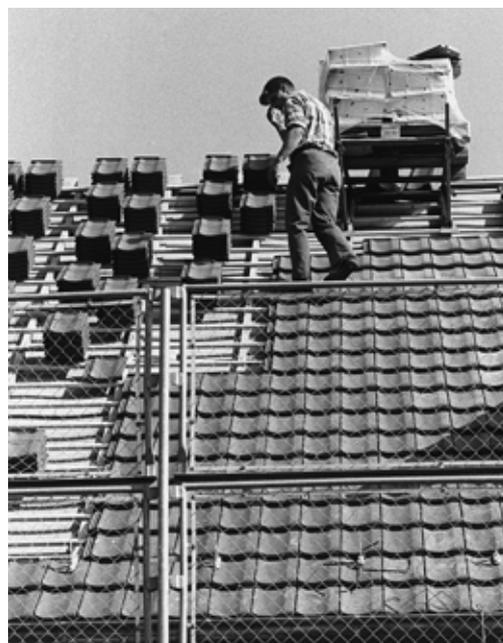
Fig. 6: sur les toits pentus, une paroi de protection pour couvreurs avec un grillage offre une protection optimale contre la chute de personnes, d'objets et de matériel.
