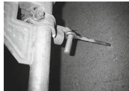
Fig. 2: ancrage résistant à la traction et à la pression, composé d'une cheville de forage et d'un piton à vis suffisamment résistant.
